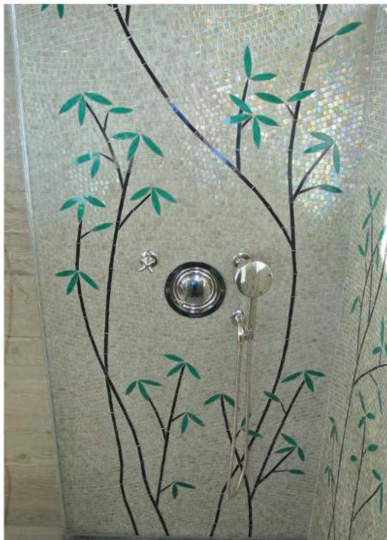
La mosaïque a été fabriquée en Angleterre avec du verre de 5 mm d'épaisseur. Un modèle unique, vrai défi pour le carreleur, qui a dû ajuster les plaques de façon à faire «courir» les motifs d'un mur à l'autre avec beaucoup de précision.
