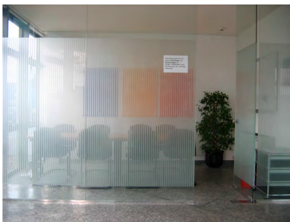
Illustration 7 Vitrage pourvu de bandes contrastantes
