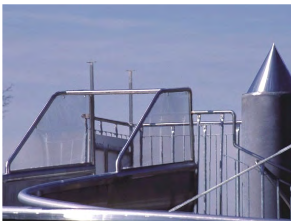
Illustration 52 Élément conique coiffant la colonne porteuse principale
