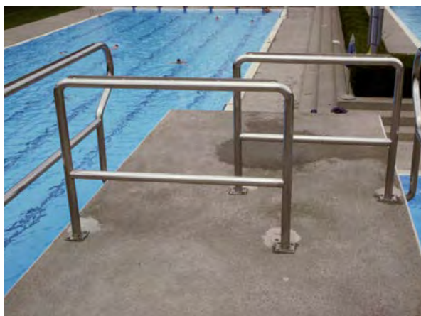
Illustration 37 Plate-forme de plongeon avec chicane
