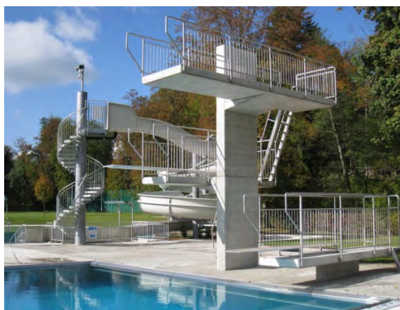
Illustration 45 Garde-corps conforme à la norme SIA 358
