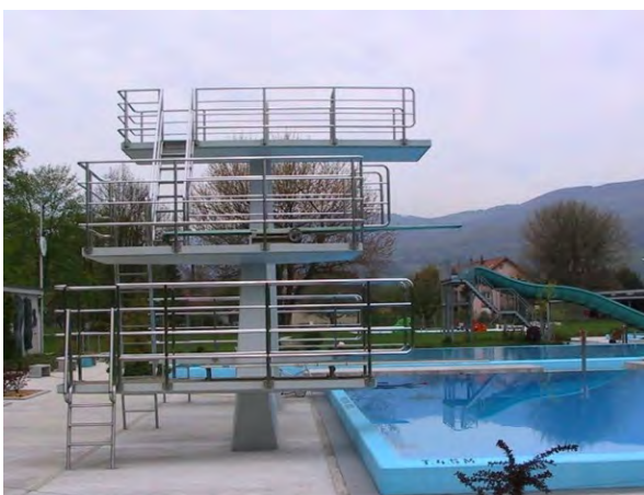
Illustration 46 Garde-corps conforme aux règles de la FINA
