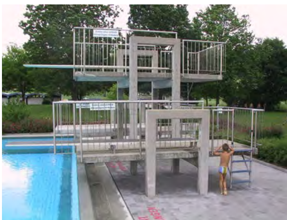
Illustration 44 Plongeur avec protections contre les chutes
