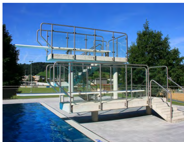
Illustration 47 Garde-corps avec verre de sécurité feuilleté (VF)
