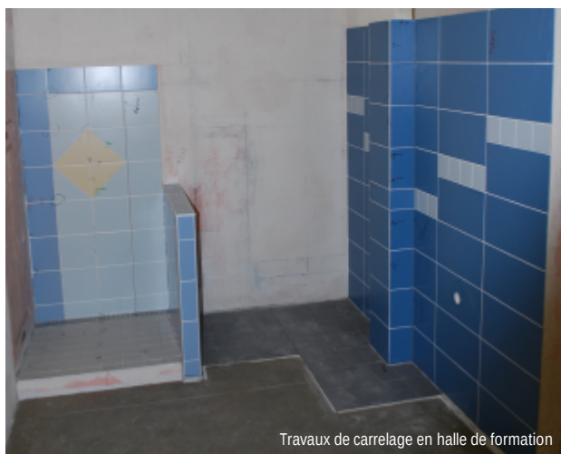
Travaux de carrelage en halle de formation
